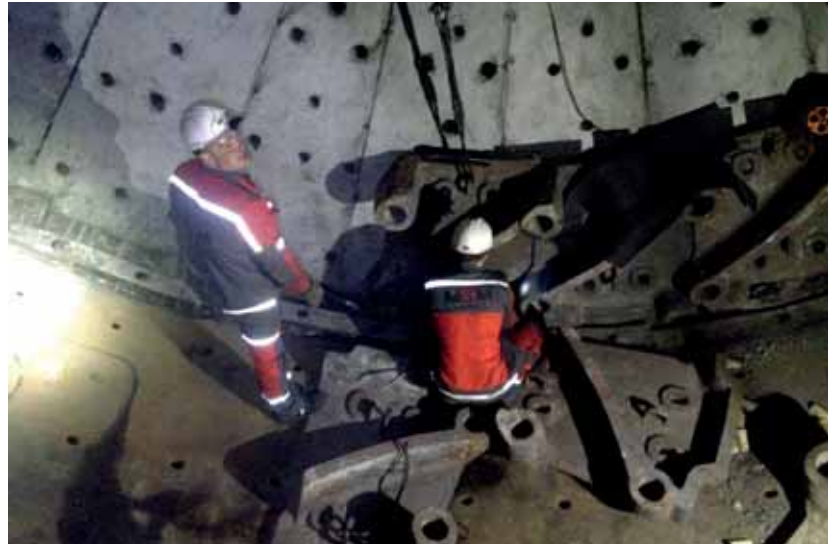
Рис. 18. Востановление стенки мельницы и установка футеровки
