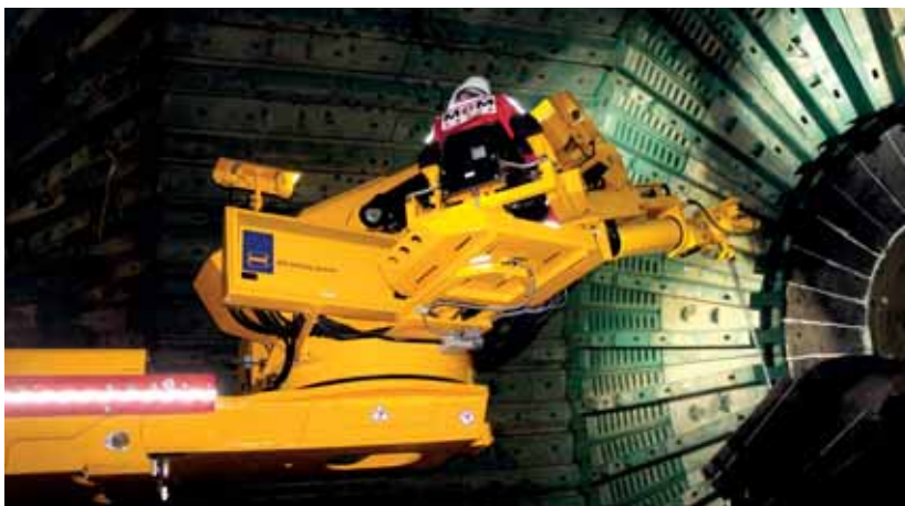
Рис. 16. Установка футеровки МПСИ 10,97х6,86 с использованием манипулятора Russell 8
